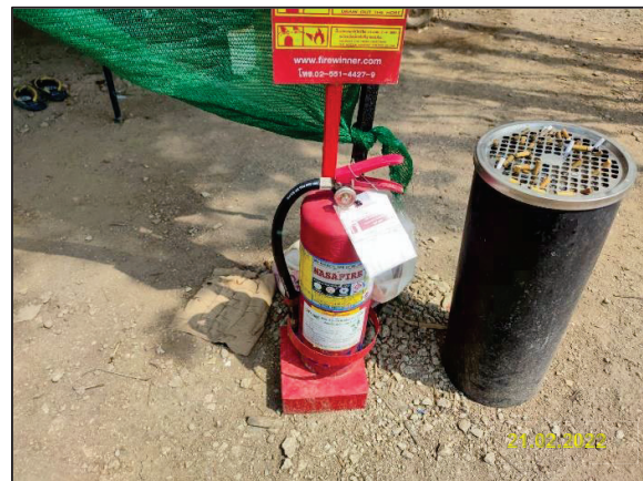
ฉ) เครื่องดับเพลิงชนิดผงเคมีแห้งบริเวณที่มีกิจกรรมก่อสร้าง
