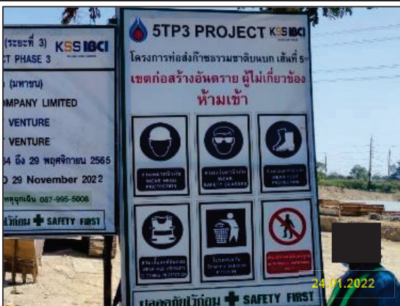
ช) การติดตั้งป้ายเตือนแสดงเขตหวงห้ามที่อาจเกิดอันตรายในเขตพื้นที่ก่อสร้าง
